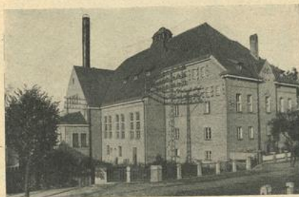
Kraftwerk und Schallhaus Marienwerder Westpr.
